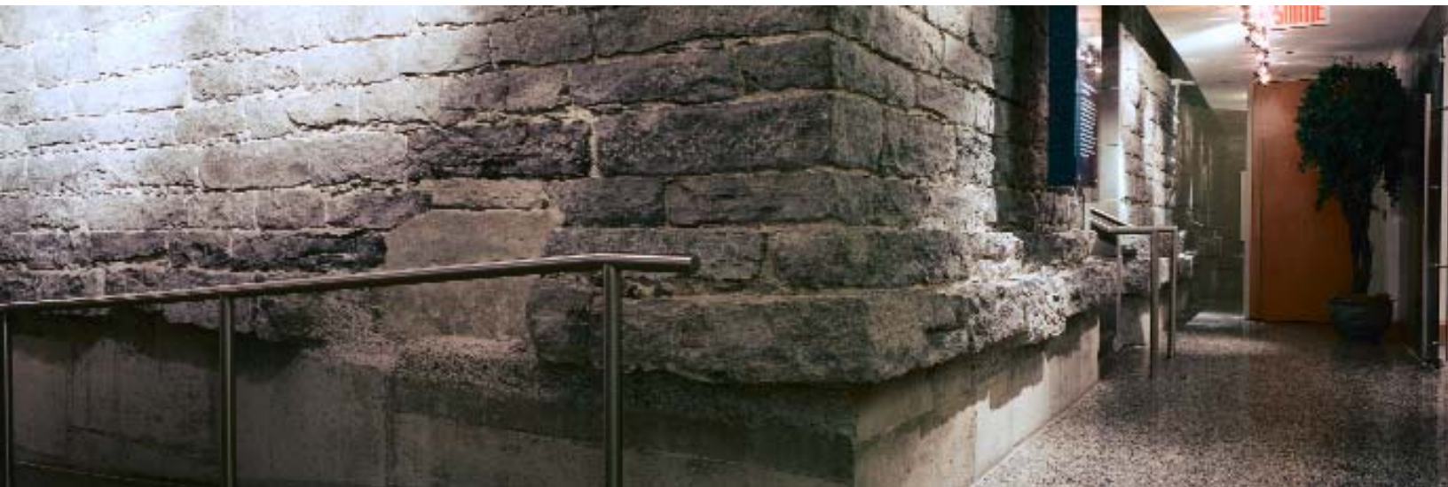
Les murs de fondation en maçonnerie, surélevés sur le sous-oeuvre en béton.
