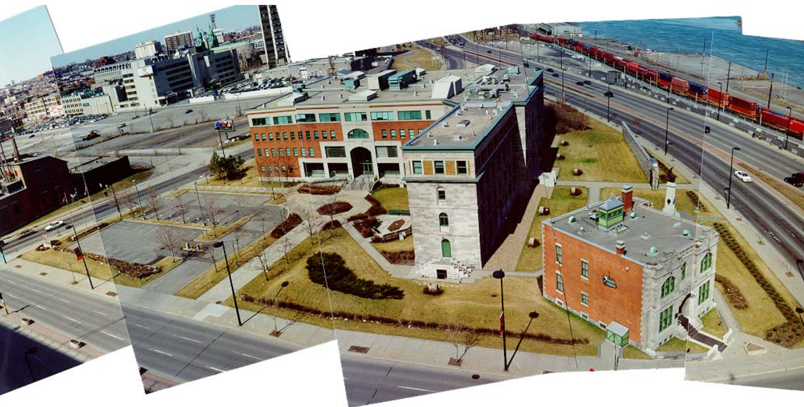
Vue d'ensemble du site en 1999, avant la construction de la Galerie du Gouverneur.
