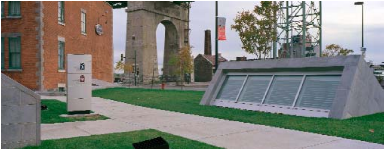
La pierre calcaire est utilisée pour créer une unité de langage dans les nouvelles interventions et permettre de régler les interfaces entre les espaces souterrains et les sous-sols des bâtiments existants, qui sont 2 ou 3 pieds plus élevés que le niveau de sol de la Galerie.
