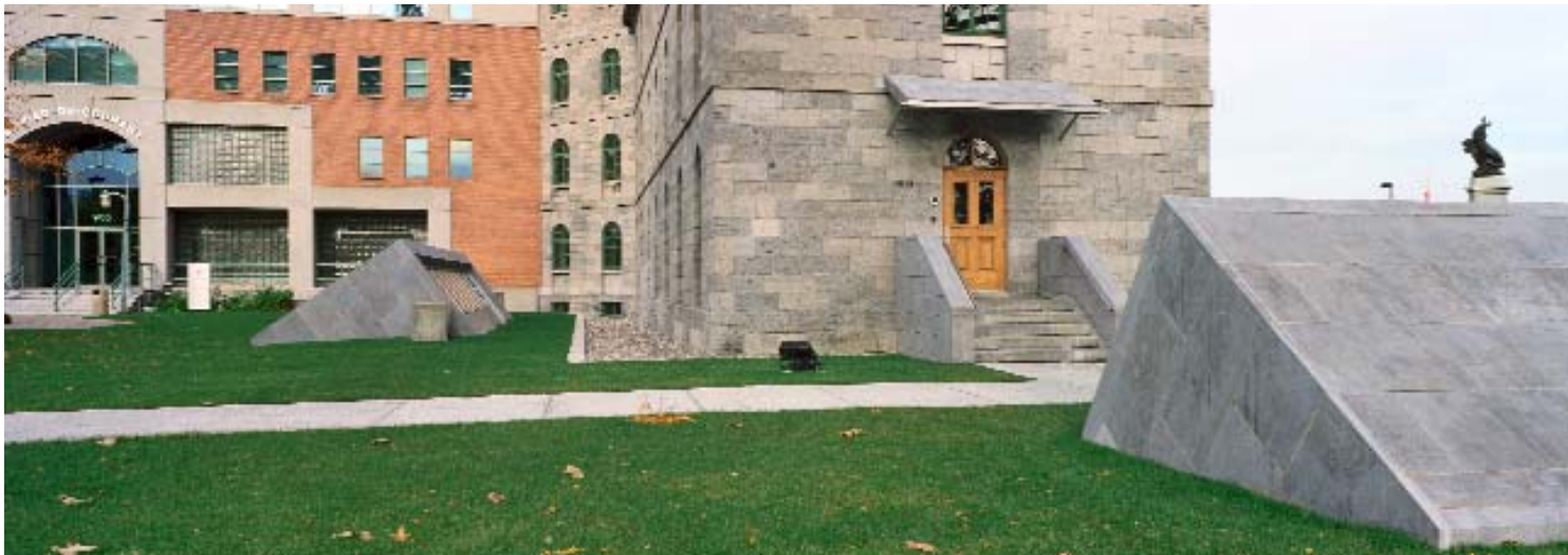
Des lanterneaux en pierre taillée émergent du sol.
