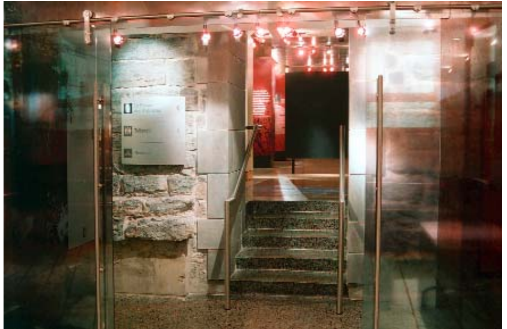
Nouveau sol en terrazzo et escalier de transition entre les nouveaux espaces et les espaces existants.
